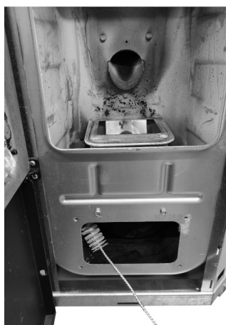
Fig. 70 - Reinig met pijpenwisser
