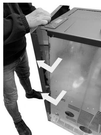
Fig. 39 - De zijpanelen verwijderen
