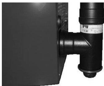
Fig. 64 - Reiniging rookleiding
