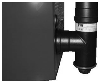
Fig. 28 - Fume conduit cleaning
