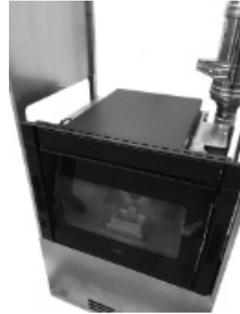
Fig. 59 - Plaatsing van het inbouwelement
