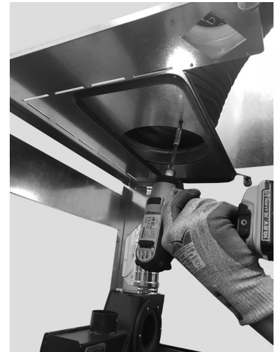
Fig. 67 - Bevestiging flexibele buis
