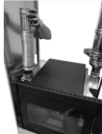
Fig. 61 - Plaatsing van het inbouwelement
