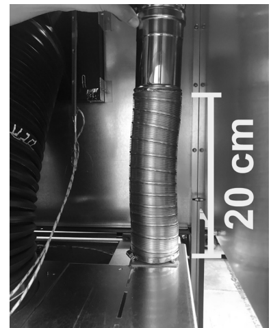
Fig. 49 - Aansluiting buigzame leiding (achteraanzicht van het inzetstuk)
