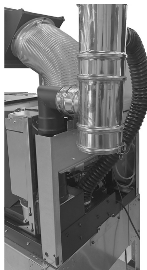
Fig. 78 - Aansluiting concentrische buis + verbrandingsluchtslang
