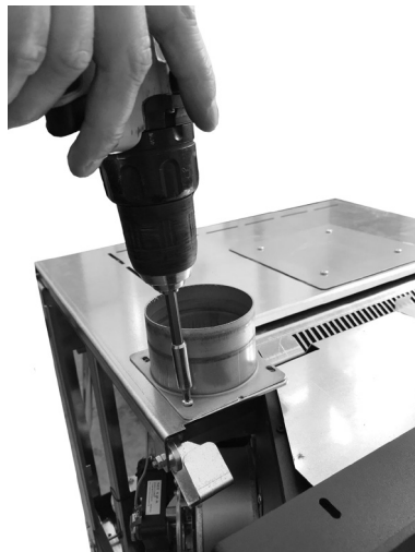
Fig. 48 - De aansluiting vastzetten
