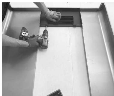
Fig. 39 - Bevestiging van de rooster
