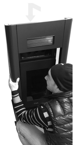
Fig. 23 - Positionering van de lijst
