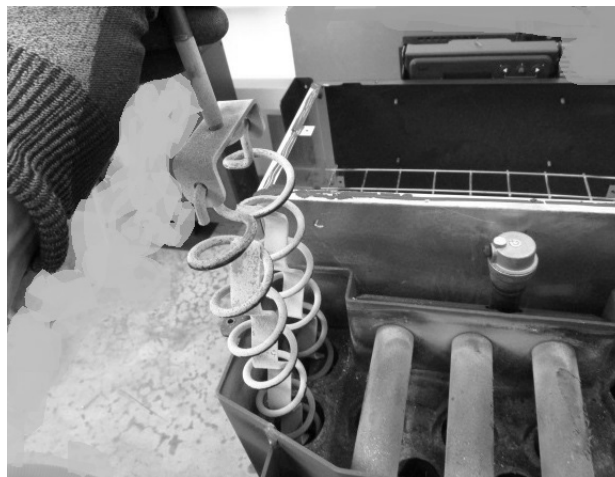
Fig. 94 - Luchtblazers vervangen indien nodig
