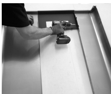
Fig. 38 - Bevestiging van het opstaand element
