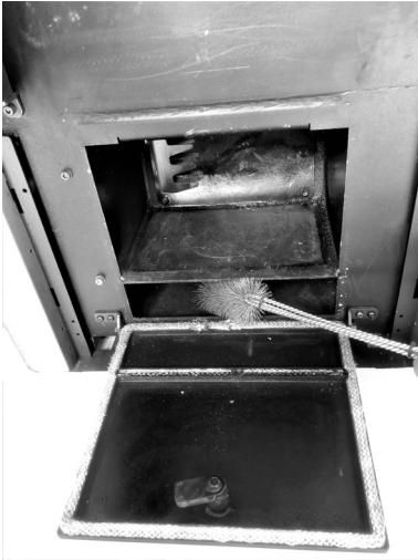
Fig. 81 - Reinig met pijpenwisser
