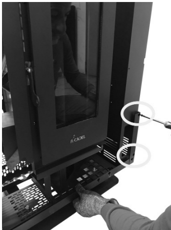
Fig. 26 - Bevestiging onderste beugel
