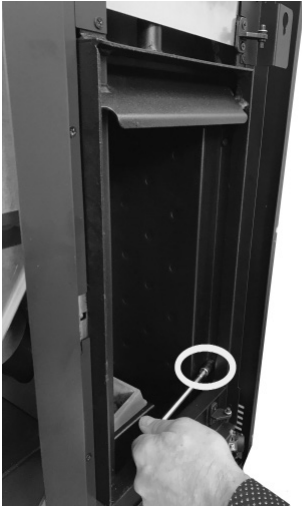
Fig. 69 - Verwijder de schroef 1
