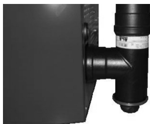
Fig. 65 - Pulizia canale da fumo
