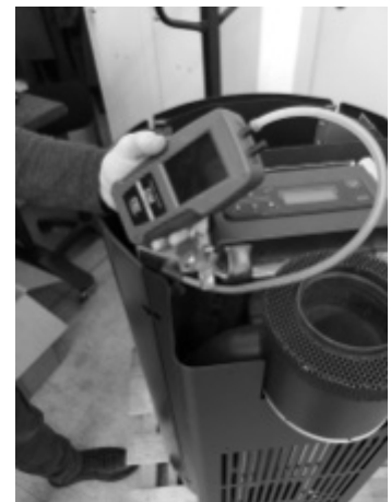
Fig. 64 - Collegamento pressostato digitale 2
