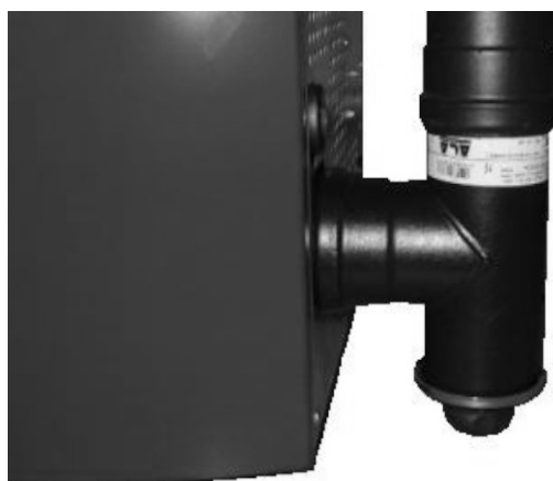
Fig. 54 - Nettoyage du conduit de fumée
