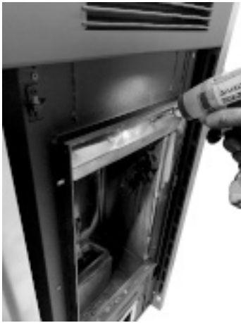
Fig. 55 - Retirer le déflecteur
