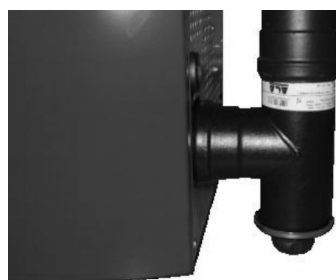
Fig. 45 - Fume conduit cleaning
