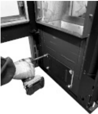
Fig. 54 - Remove the cap
