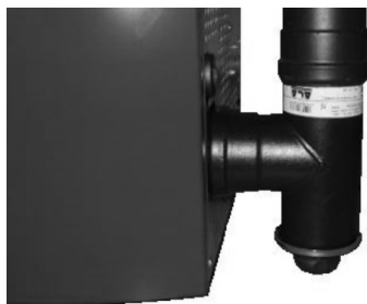
Fig. 47 - Limpieza canal de humos
